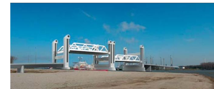
De nieuwe Botlekbrug.
