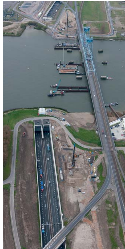
Een overzicht van de Botlekarea van oost naar west. Op de oostelijke oever is de Woltman stelling van Terracon bezig met Terr-econ palen, in het water de bouwputten voor de pijler 30, 40 en 50 en op de westelijke oever is de combinant bezig met het heien van prefab palen.
