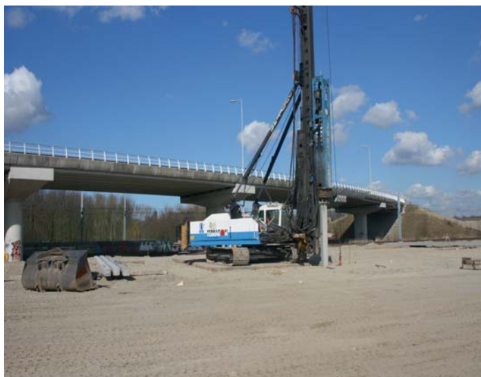
De PM 25 stelling in actie bij het heien van een van de 2000 "matras"palen voor Vaanplein.
