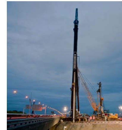
De Woltman A900 stelling tijdens nachtwerkzaamheden voor het Erasmusviaduct: prefab palen van 29 m.
